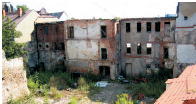
Hofseite Hainwald 2 vor Baubeginn
